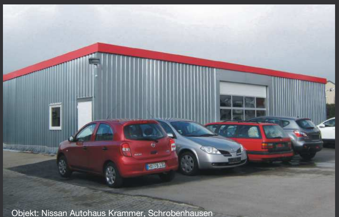
Objekt: Nissan Autohaus Krammer, Schrobenuhausen
